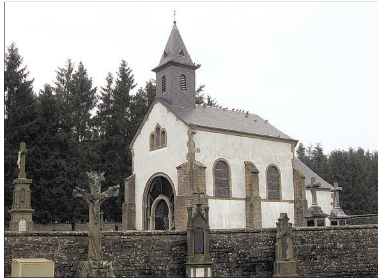
La chapelle de Schoenberg, construite en 1700 et située en plein milieu du cimetière du village de Kehlen, mais bien en dehors de cette localité, était voilà 250 ans le siège d'une importante paroisse luxembourgeoise comprenant les localités de Dondelange, Kehlen, Keispelt, Meispelt, Nospelt, Olm et Roodt ainsi qu'une partie de Cap-Capellen et de Kopstal (Photo: Victor Racine)
